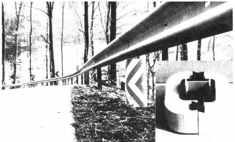
Der „eingepackte“ Doppel-T-Träger mit zusätzlicher aufgebracht optischer Signalwirkung.
