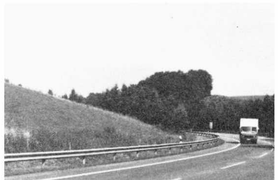
Die gesamte Lei(d)tplanke in der Innenkurve ist überflüssig; dahinter ist freies Feld (B 507 bei Lohmar).
