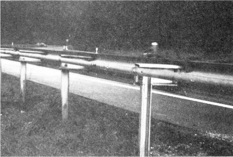
B 507 bei Lohmar: Mitten in einer Reihe IPE-Träger stehen schon neue Sigma-Pfosten nach einer Reparatur. Foto: Henning Knudsen
