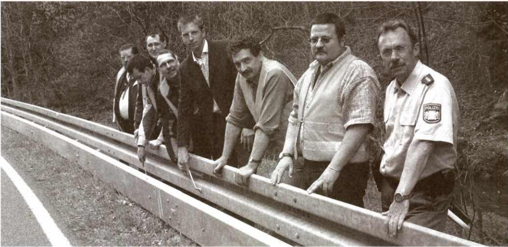
Den ersten Unterfahrschutz nach dem Euskirchener Modell in Bayern installierte der BVDM im Eisbachtal.
