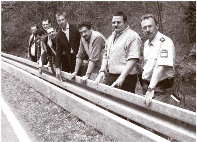
Den ersten Unterfahrschutz in Deutschland nach dem so genannten Euskirchener Modell installierte der BVDM aus Spendengeldern.
