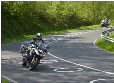
Die Markierungen sollen dafür sorgen, dass Motorradfahrer in den Linkskurven außen fahren. Fotos: Lenzen
