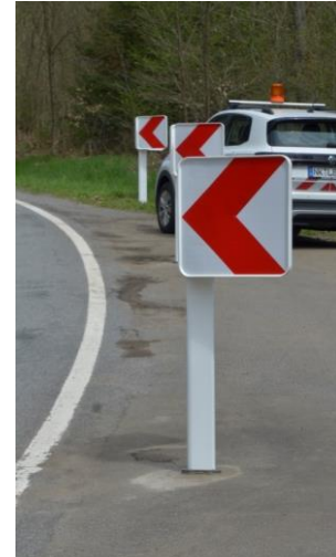
Die flexiblen Kurvenleittafeln an der L 156. Foto: Lenzen
