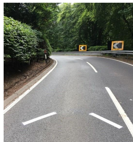
Einfache Striche sollen den Motorradfahrer auf die richtige Linie leiten. Fotos: transport scotland
